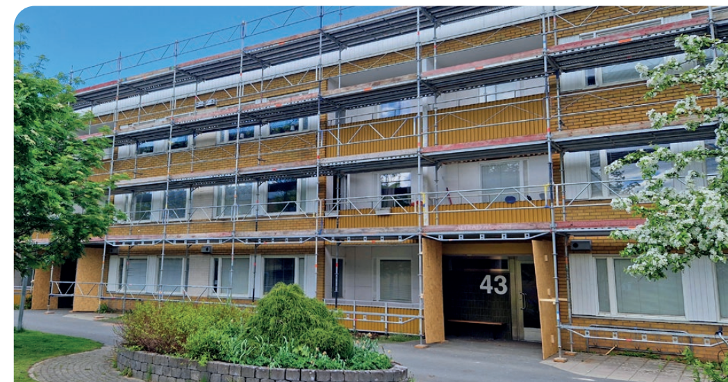
Kv. Doktorn är ett av Finnvedsbostäders största underhållsprojekt någonsin och innefattar en rejäl energieffektivisering när samtliga fönster och fönsterdörrar byts ut. Även tilläggsisolering kommer att utföras vid balkonger och på vindarna och på delar av fasaderna.
